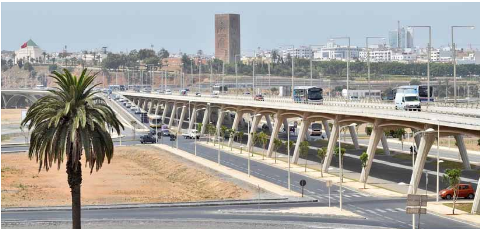
Viaduc d'Accès au Pont Hassan II – Rabat
